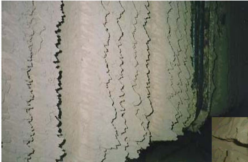
Superheater Slagging
